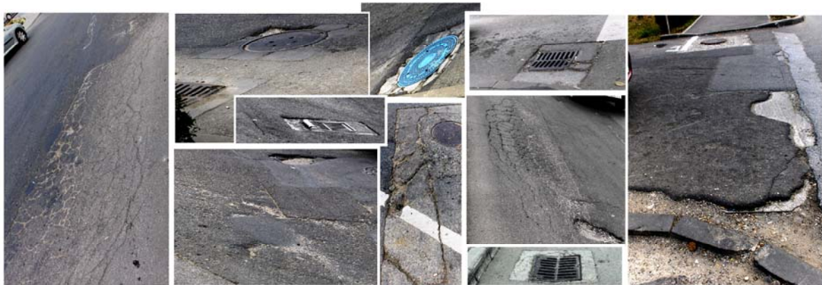
Figura 2. Obstacole și deformații întâlnite pe suprafața rutieră
