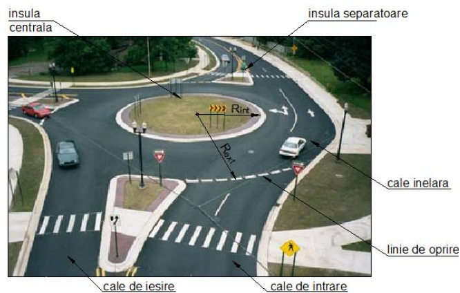
Fig.5 Elementele unui sens giratoriu modern
