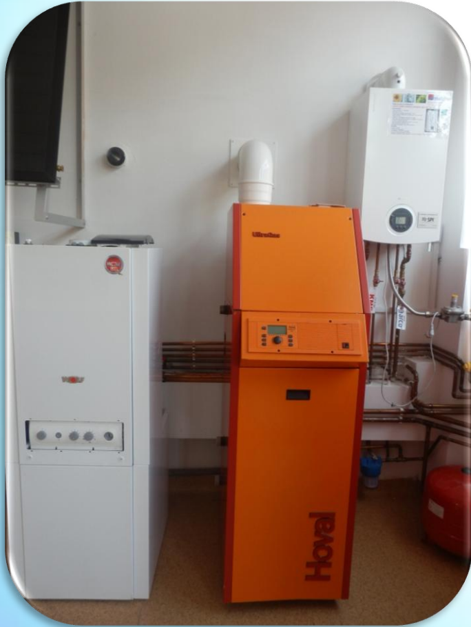
Echipamente de producere a agentului termic
