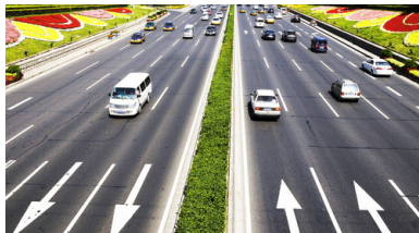
Figure: Controlul traficului
